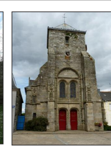
Eglise Saint-Sauveur, à Corlay
