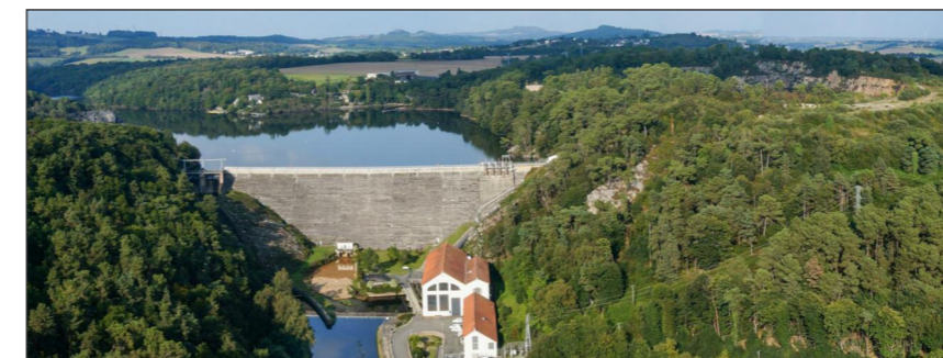
Vue du barrage
