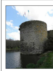
Restes du château, à Corlay
